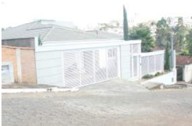
FOTO 03 – Visualiza a frente do imóvel 1 avaliado, para a Rua Madri, nº 480 – Condomínio Chácara Primavera.
