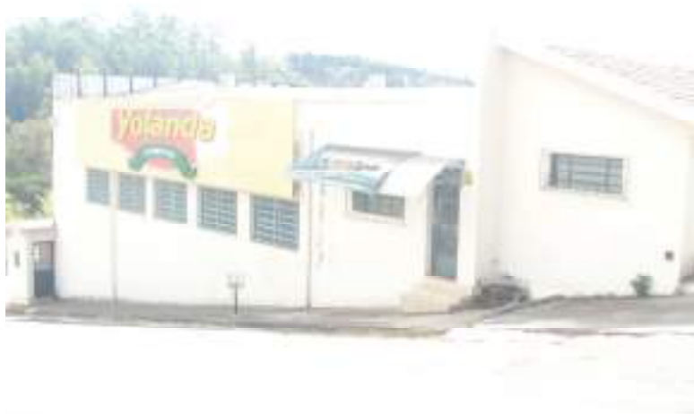
FOTO 04 – Visualiza a lateral do imóvel 2 avaliado, para a Rua Tamar - Loteamento Jardim Canaã.
